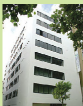
築地神経科クリニック ＜東京都中央区築地＞ 東京ガンユニットセンター(18床)
